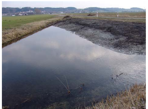
Im Winter 2008 neu angelegtes Absetzbecken am Weidgraben, das für eine verringerte Verschlammung und damit für eine geringere Unterhaltungsintensität an den unterstromigen Grabenabschnitten sorgen wird.
