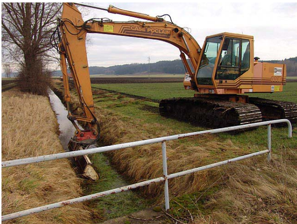
Ein Mähkorb mit Schneidwerk ist eine schonende Methode, sofern nur knapp unter der Wasseroberfläche gearbeitet wird und vereinzelt kleine Vegetationsinseln im Gewässer verbleiben
